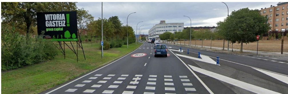
Figura 21. Ejemplo de señalización de zona urbana en Vitoria-Gasteiz
