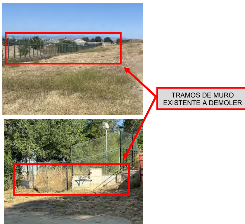
Imagen 9. Demolición de cerramiento.
